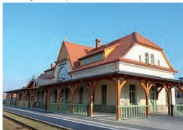
Budynek dworca od strony peronu
