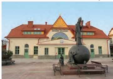
Budynek dworca od strony placu św. Mikołaja
