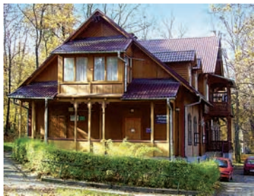
Willa „Pod Aniołem” , obecnie po porzeczce, ul. Parkowa 5, rok budowy 1870
