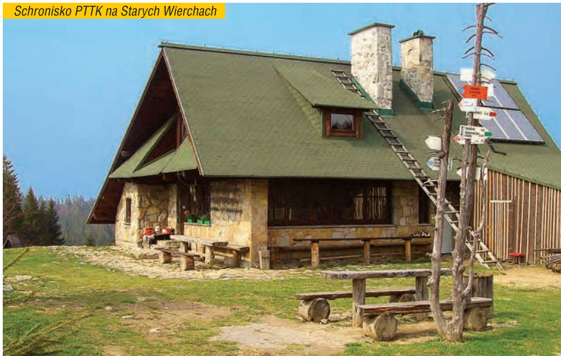
Schronisko PTTK na Starych Wierchach
